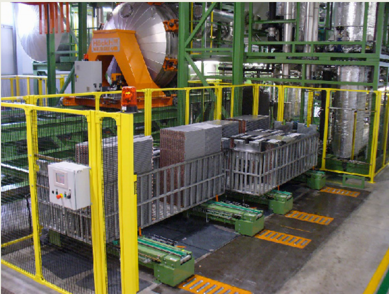
In dieser Station werden je Charge sechs Einzelgestelle zum automatischen Laden bereitgestellt
