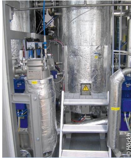
Der Anlagenaufbau ist übersichtlich gegliedert: Der Reinigungszugang zu den stehenden Tanks im wässrigen Modul ist komfortabel mit einem Aufstieg versehen.
